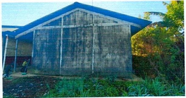
Foto 6: Alisado de la pared para evitar filtracion del agua, y la humedad.
